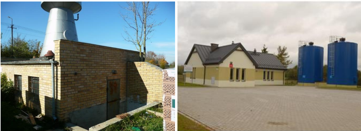
Zdjęcie Stacji uzdatniania wody w Gulbieniszkach przed przebudową oraz stan aktualny
