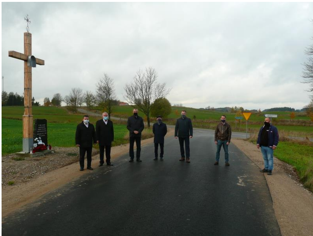
Rysunek 3.4.2. Odbiór techniczny przebudowanej drogi
