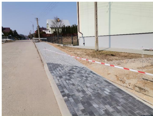
Stan chodnika w trakcie budowy.
