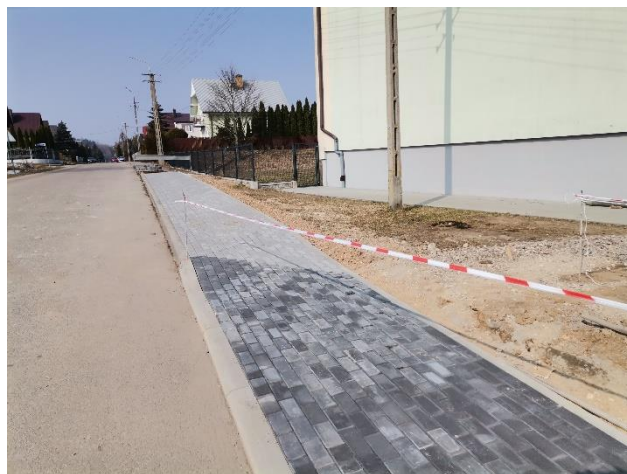
Stan chodnika w trakcie budowy.
